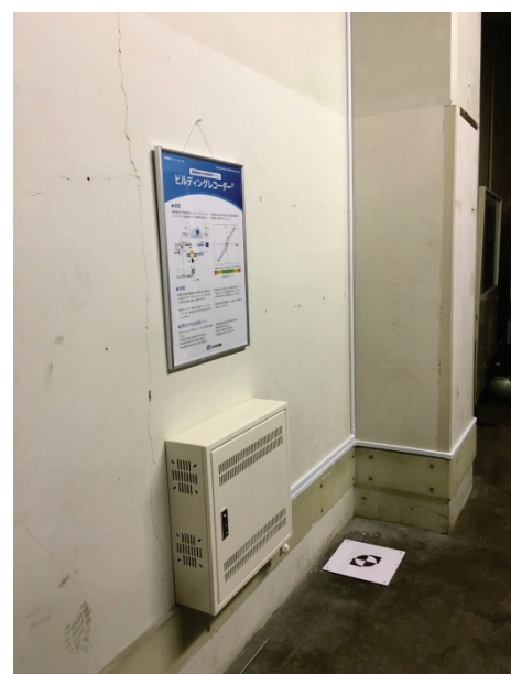
制御盤及び下階床スラブ上面に設置したターゲット
