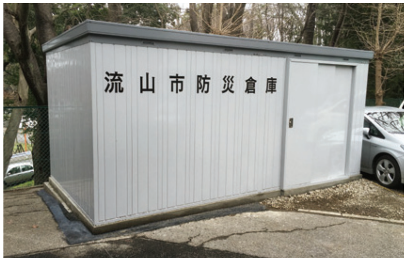
② 防災備蓄倉庫整備事業(西初石小学校)
